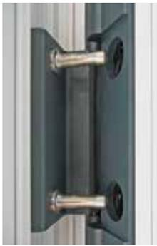
Rollenband mit Bandseitensicherung
